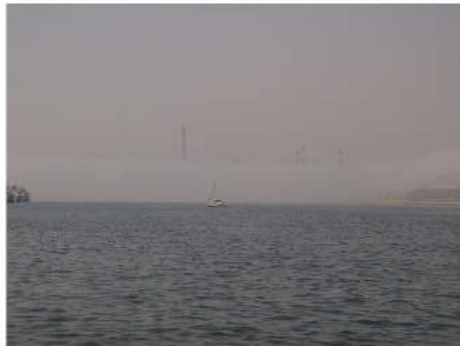
[ 31 May 2014 & 01 June 2014 東方より神領加古川 原料岸壁方面を望む ]
